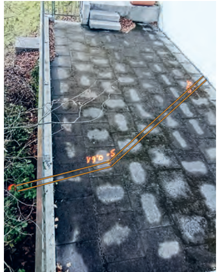
Verlauf der zu erneuernden Abwasserleitung
