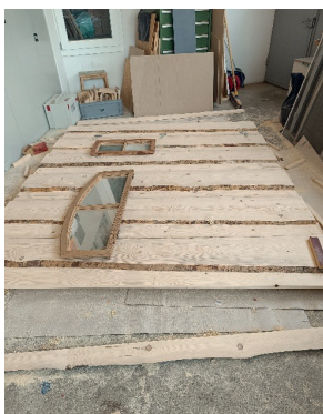
Anfertigung Innenausbau Jugendraum
